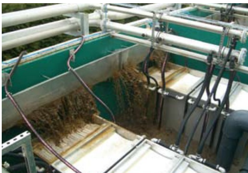
Рисунок 12. РЕКА KROEF, крупнейшие в Нидерландах сооружения для очистки промышленных сточных вод с помощью MBR производительностью 2,880 м 3 /сутки
