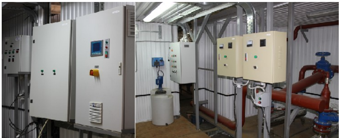
Рис. 3. Вид внутри технологического павильона МБР-200 для поселка в Московской области в процессе заводского изготовления
