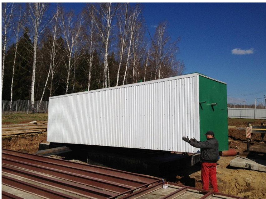
Рис. 5. Монтаж емкостного блока МБР-200 на площадке в Московской области
