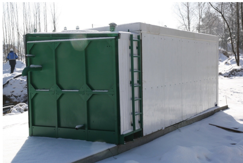
Рис. 4. Монтаж технологического павильона с баком обратной промывки установки МБР-125 на площадке в Ленинградской области
